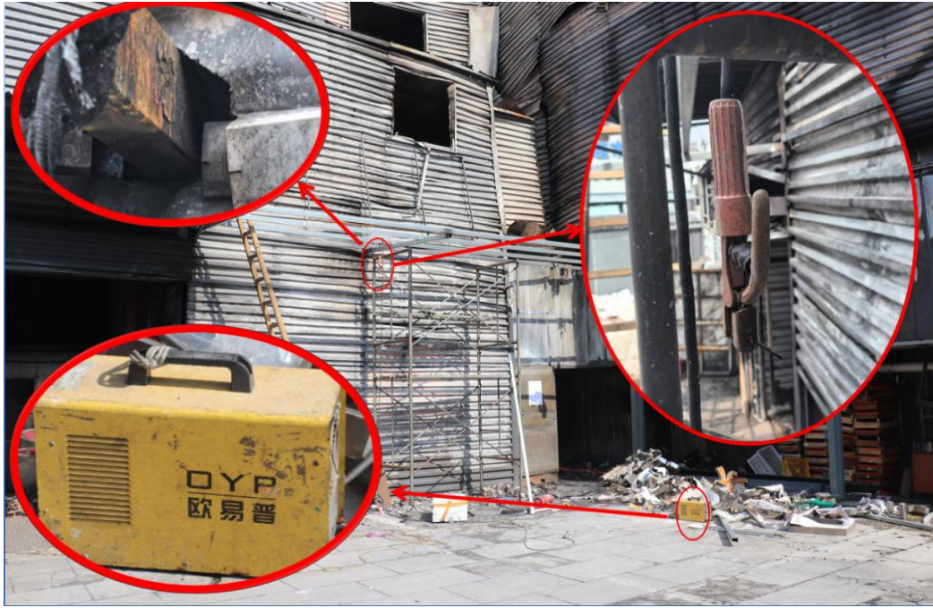
(图9 现场电焊作业相关设备)
